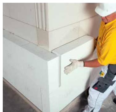
Монтаж плит Multipor на углах здания
