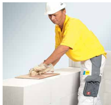
Выравнивание с использованием шлифовальной доски
