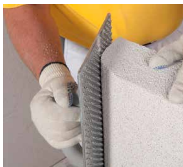
Создание изогнутых форм с помощью шлифовальной доски Multipor
