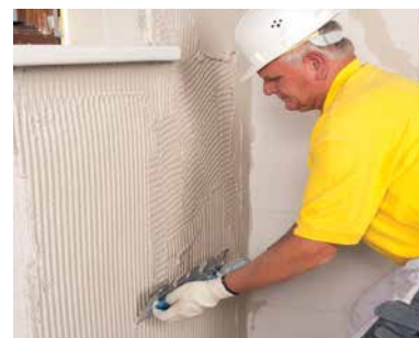
Нанесение армирующего слоя зубчатой гладилкой
