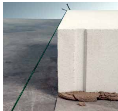
Шнур-причалка для ориентации высоты укладки блоков
