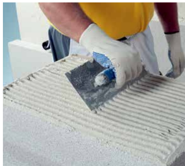
Нанесение легкого раствора Multipor
