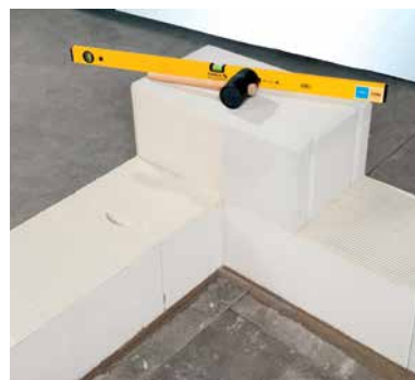
Закладка углового элемента второго ряда
