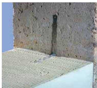
Примыкание к железобетонной колонне
