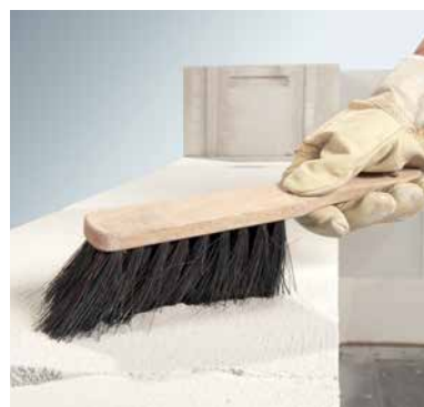
Удаление пыли и загрязнений при помощи щетки
