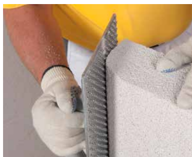
Создание изогнутых форм с помощью шлифовальной доски Multipor
