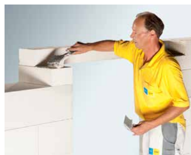
нанесение раствора для тонкошовной кладки YTONG
