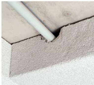
Монтаж отверстий в плите для коммуникаций
