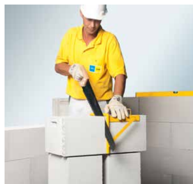
Резка вручную
