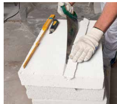
Монтаж отверстий в плите для коммуникаций
