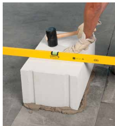
Выравнивание с помощью уровня и резинового молотка
