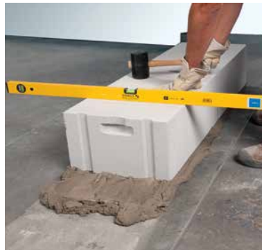
Выравнивание с использованием уровня и резинового молотка
