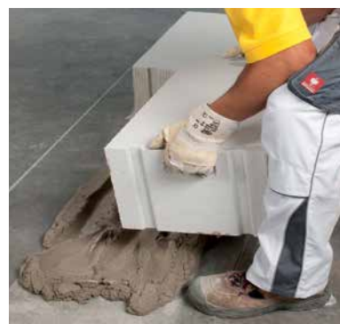
Установка первого ряда блоков
