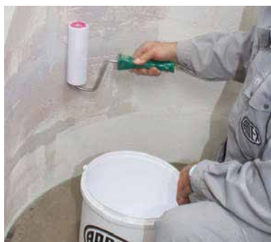
Нанесение влагостойкого грунтового покрытия
