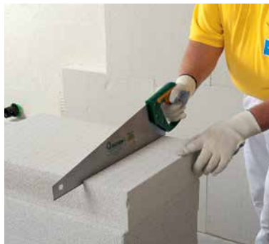
Резка плит ножовкой с мелким зубом
