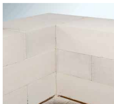
Правильное соединение угловых элементов
