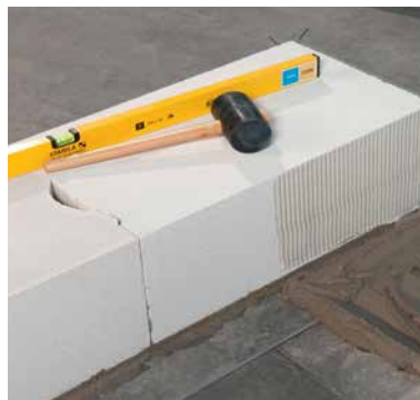
Готовая кладка 1-го ряда на растворе
