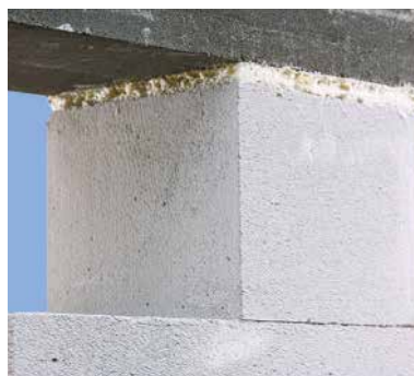
Примыкание к железобетонному ригелю
