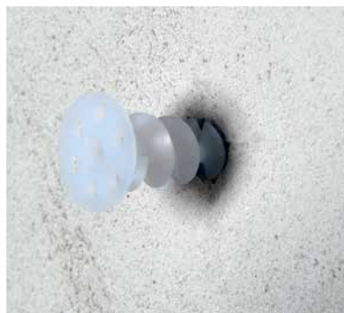
Монтаж спирального дюбеля
