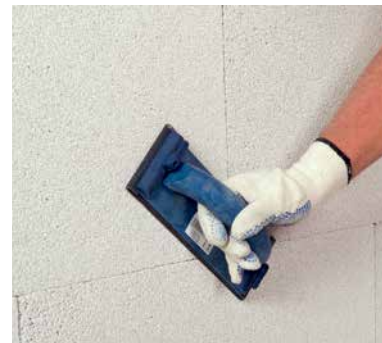
Выравнивание поверхности шлифовальной доской Multipor
