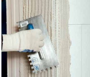
Монтаж углового профиля ПВХ с сеткой
