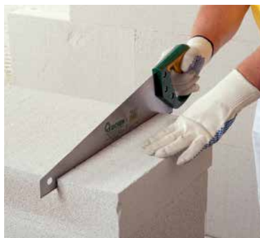
Резка плит ножовкой с мелким зубом
