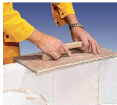
Обработка поверхности кладки шлифовальной доской
