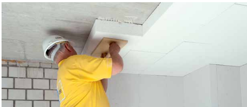
Плотная стыковка с предыдущей плитой
