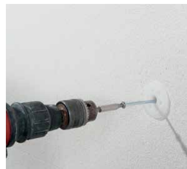
Установка тарельчатых дюбелей
