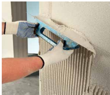
Нанесение армирующего слоя
