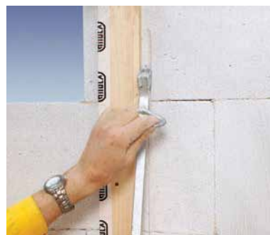
Изготовление каналов для прокладки электропроводки
