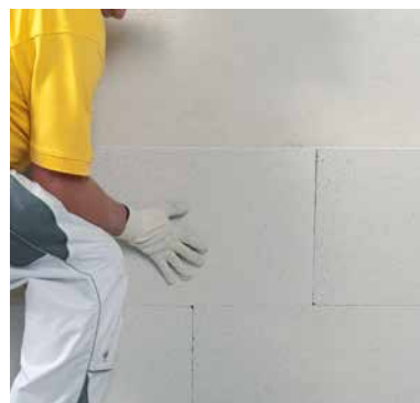
Сдвиг плиты с небольшим прижимом, плотная состыковка с предыдущей плитой
