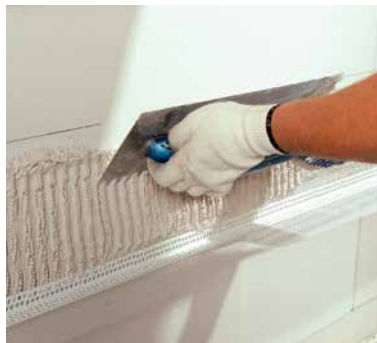
Установка углового профиля ПВХ с сеткой на основание
