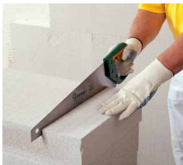
Резка плит ножовкой с мелким зубом
