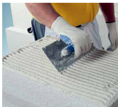
Нанесение легкого раствора Multipor
