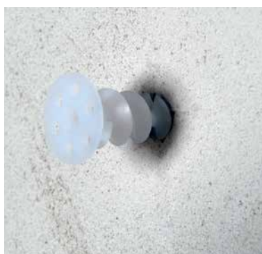
Монтаж спирального дюбеля
