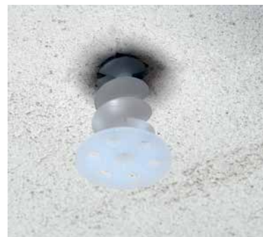
Монтаж спирального дюбеля
