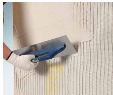
Монтаж сетки из стекловолокна в армирующий слой Multipor
