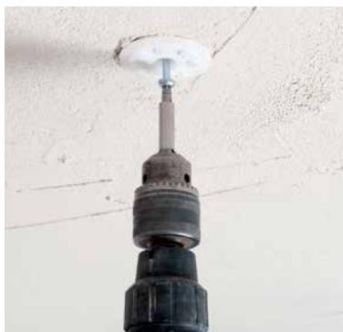
Монтаж тарельчатых дюбелей
