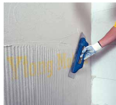
Утапливание сетки из стекловолокна в верхнюю треть армирующего слоя
