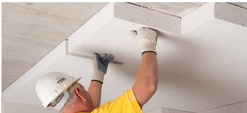
Прижатие плиты к стене на расстоянии 3 см от предыдущей плиты
