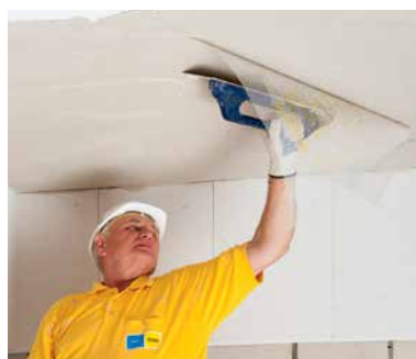
Утапливание сетки из стекловолокна в верхнюю треть армирующего слоя
