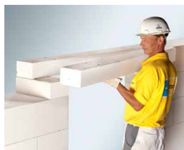
Укладка перемычки ПН125
