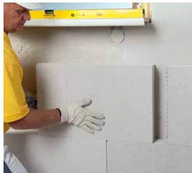
Прижатие плиты к стене на расстоянии 3 см от предыдущей
