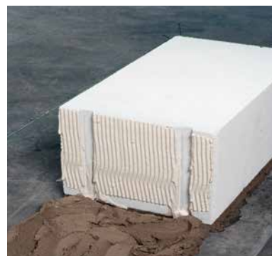
Вертикальный шов первого углового элемента
