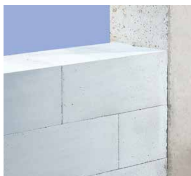
Примыкание к железобетонному каркасу
