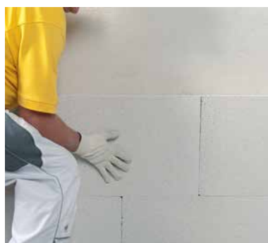
Сдвиг плиты с небольшим прижимом, плотная состыковка с предыдущей плитой
