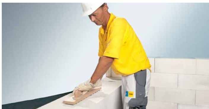
Шлифовка с использованием рубанка
