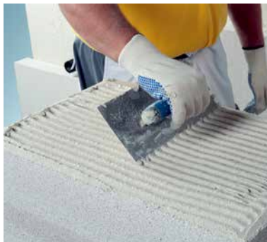
Нанесение легкого клеевого раствора Multipor
