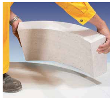
Укладка первого ряда дугообразных блоков
