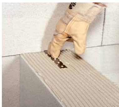
Закладка связи в шов примыкающей стены
