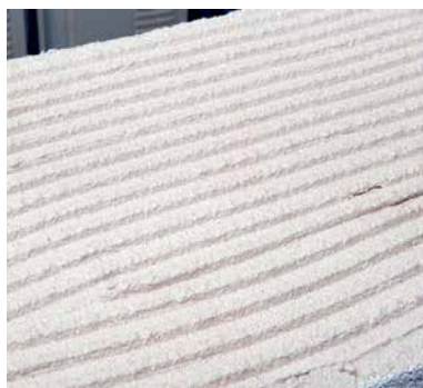
Равномерное нанесение раствора
