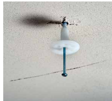
Монтаж тарельчатых дюбелей
