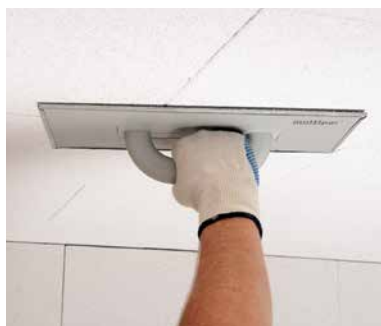
Выравнивание поверхностей плит шлифовальной доской Multipor
